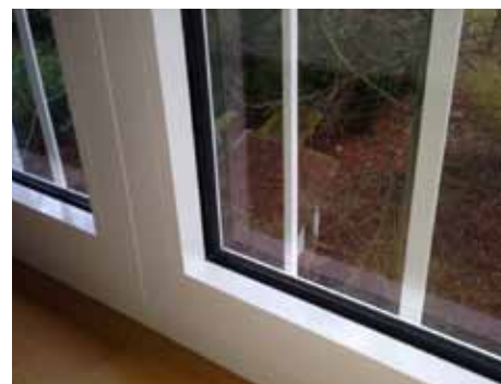
Met matzwarte ECOTEC afstandhouder: neutraal, onopvallend en thermisch onderbroken 'warm-edge'.
