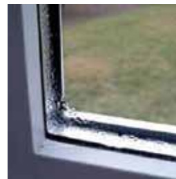
Isolatieglas met traditionele blinkende, niet thermisch onderbroken afstandhouder.
